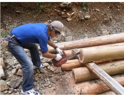
伐採材の皮むき作業準備。骨の折れる作業。(2015・5・5)
