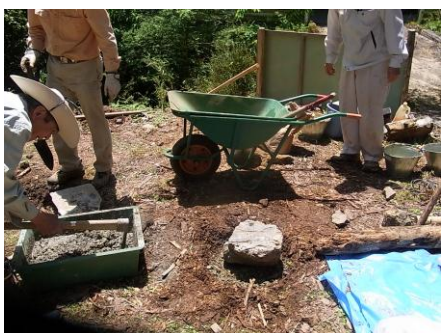
建設予定地の整地・基礎工事の様子。(2015・5・5)
