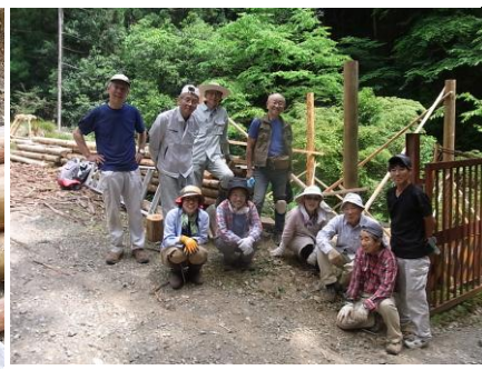
四隅の柱立て。垂直に立てるのが大変。(2015・6)
