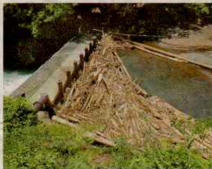
2021年5月の大雨時に大量の木々を食い止めた「流木止め」
