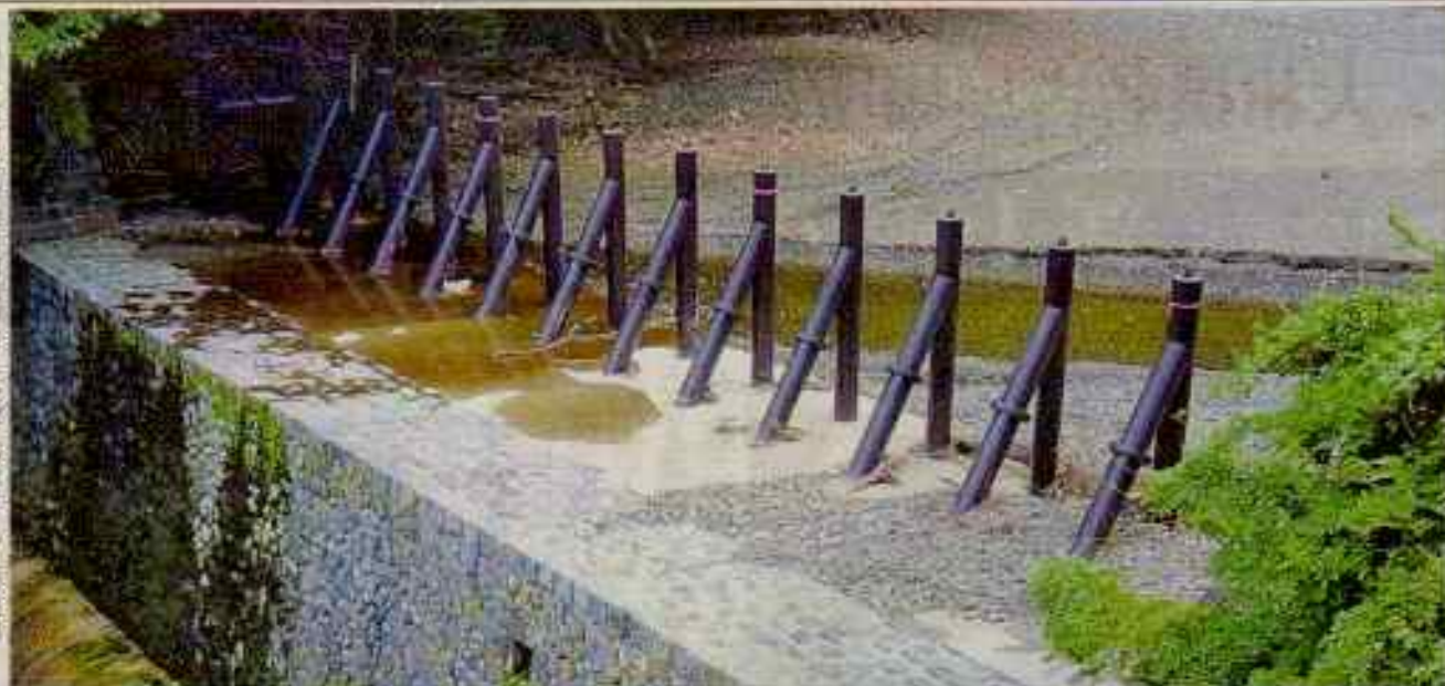
鴨川上流部の中津川向山砂防えん堤に設置された構造物
